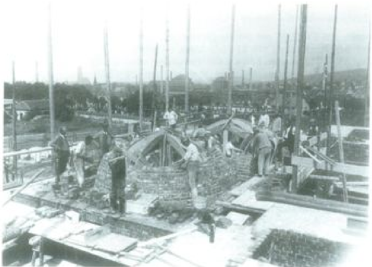
Aufmauern der Gewölbe der Kapellen im Turm 1926/27
