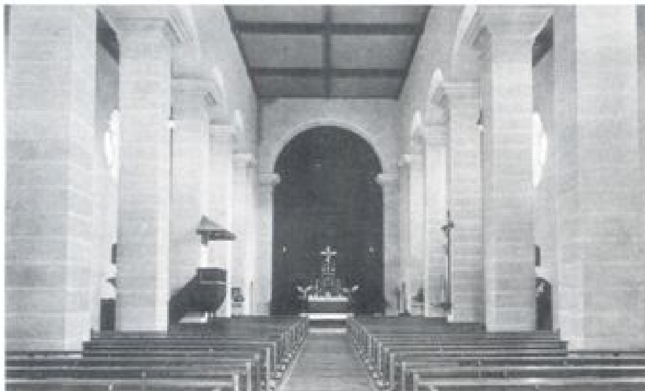
Kircheninnenraum 1927-29. Die Baustelle des Presbyteriums ist durch eine Holzwand und rote Tücher abgetrennt.
